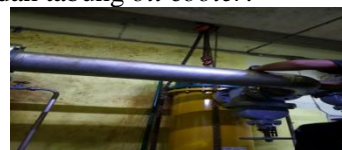
Gambaar 4. 4: pemasangan tools pembongkaran oil cooler
