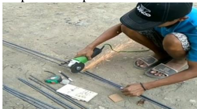
Gambar 4.2 pemotongan Besi Begel
