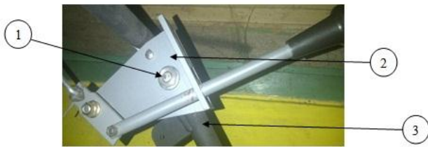
Gambar 4.14. Rangkaian Tension Rod Set
