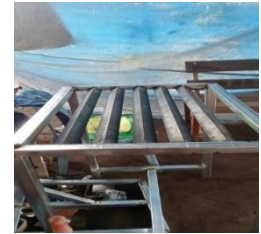
Gambar 4. 4 Proses pengelasan meja utama
