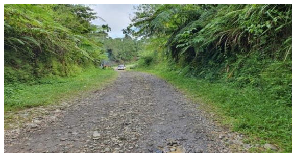
Gambar 1. Kondisi Lapangan Existing
